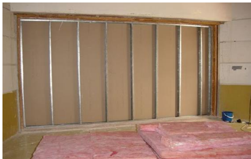
1. ติดตั้งโครงคร่าวที่ระยะ 60 ซม.
