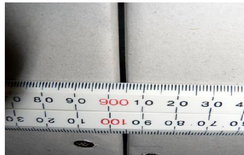
2. ติดตั้งแผ่น X-Bloc โดยเว้นระยะ 2 มม.
